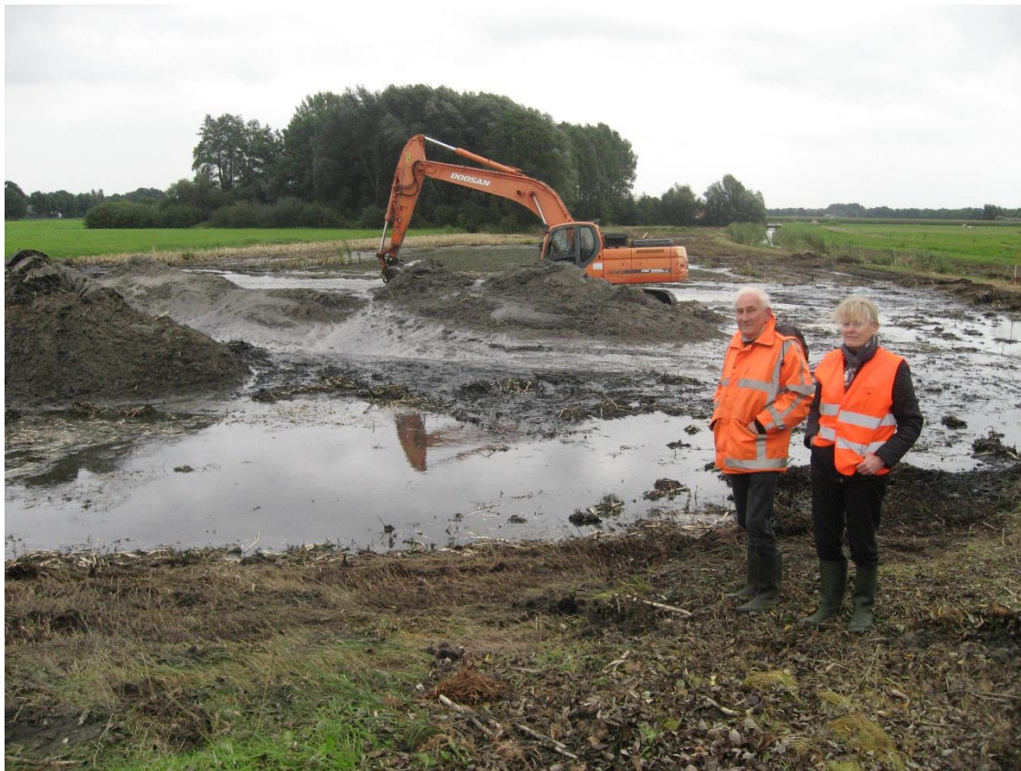
Werkzaamheden in Ramele, met toezichthouders Giny Kogelman en Wim Winterman.
